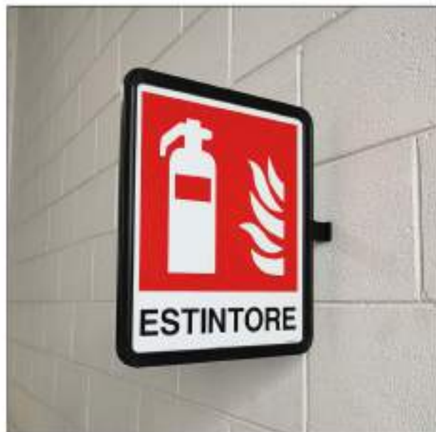
INSTALLAZIONE DI SEGNALI BIFACCIALI
